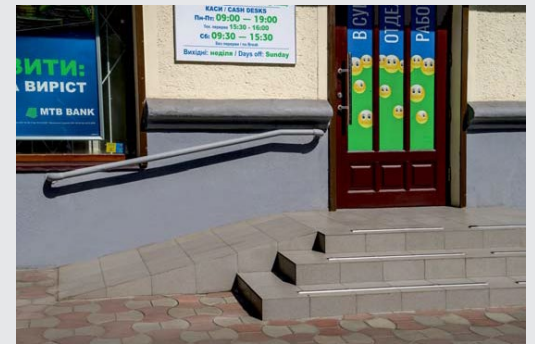
Вход в отделение, пандус с поручнем, противоскользящие ступени
