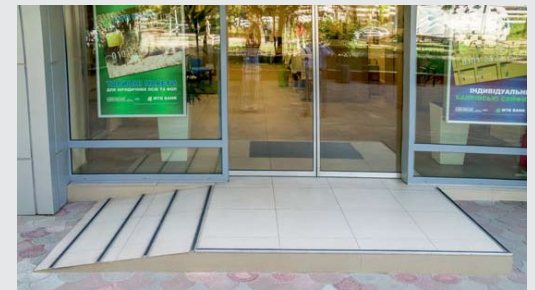
Противоскользящий пандус и входная зона в отделение
